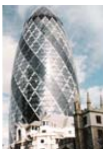
Рис. 40. Офисный центр швейцарской страховой компании «Swiss Re» в Лондоне
